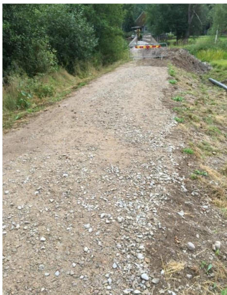
Återställning av gångväg 1 vecka
